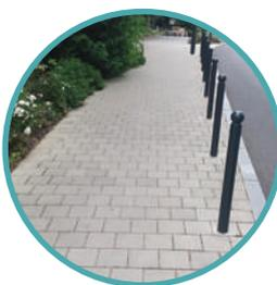
Les pavés de formats 10x20, 20x20 et 30x20 (avec ou sans écarteurs) sont compatibles pour une pose en multi-formats
